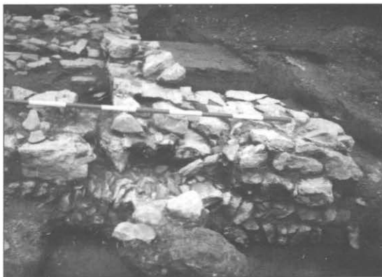
2.kép: Többszörös átépítés, 2. század vége 3. század eleje Figure 2: Multiple rebuilding works from the end of the 2 nd century and the beginning of the 3 rd century
