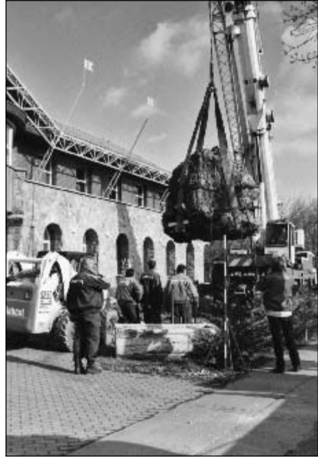
2. kép: A 14 tonnás „vízkő-pillér” új, végleges helye fölött, irányítás-leeresztés közben
