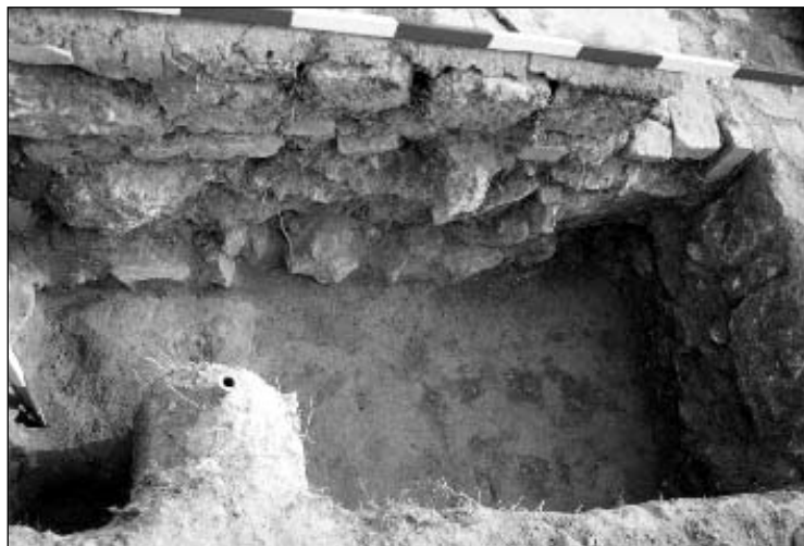
2. kép: A déli torony északi falának alapozása északról Fig. 2: The base of the northern wall of the southern tower from the north
