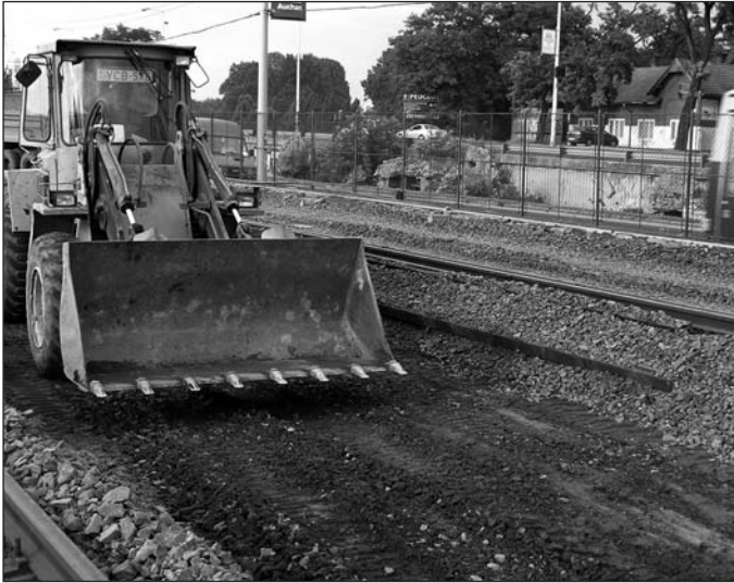
2. kép: Munkaterület a BKV-HÉV pálya mentén Fig. 2: Working area on the territory of the BKV-HÉV railroad
