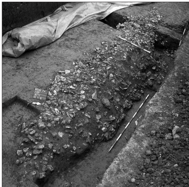
5. kép: Támfal a 22. épület területén
