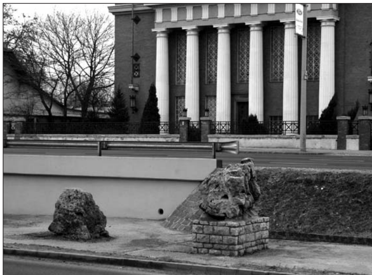
7. kép: Az aquaeductus pillérsora a helyreállított támfallal
