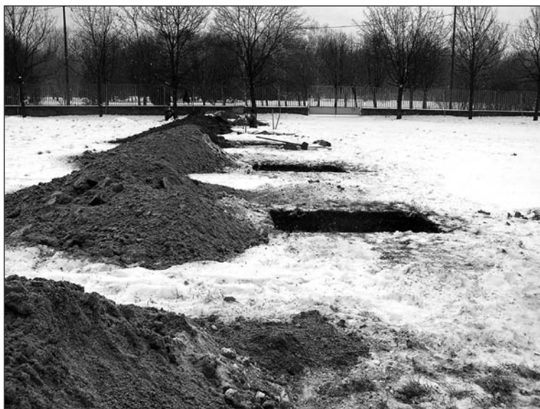
3. kép: Az alapgödör sor északi gödörsora kelet felől. Előtérben a 10. alapgödör
