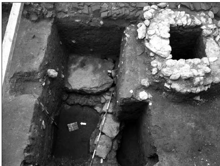
6. kép: Gyűjtőcsatorna tisztítóaknával és egy becsatlakozó kisebb csatornaággal. Fig. 6: Collection main with a manhole and a smaller incoming channel branch
