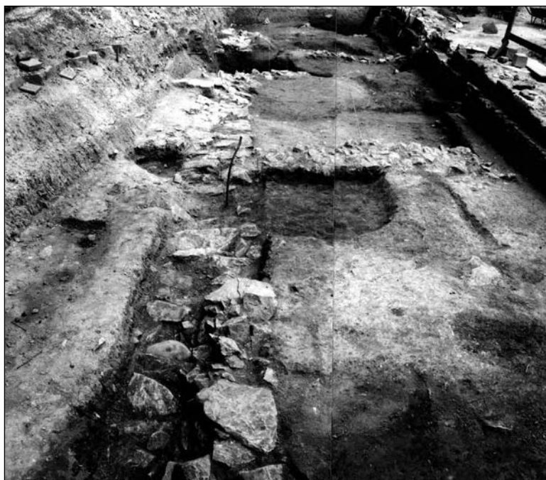
2. kép: A 16. századi könnyűszerkezetes ház alapozása Fig. 2: Foundation of the light-construction house from the 16th century
