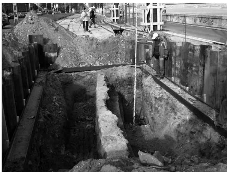
6. kép: Korábbi parti támfal maradványai a 4. akna területén Fig. 6: Section from an earlier retaining wall of the embankment found in Shaft 4; Buda Main Sewer
