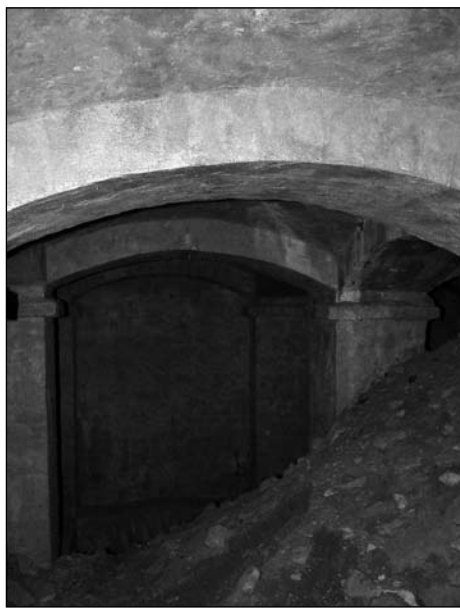
8. kép: Földalatti sajtolás közben előbukkant víztároló-helyiség az csatorna déli, Döbrentei tér felé eső részén
