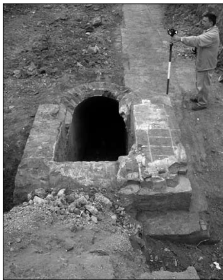
13. kép: Lejárati akna a földalatti víztároló, illetve szűrő helyiségsor keleti oldalán húzódó, észak-déli alagút északi végén
