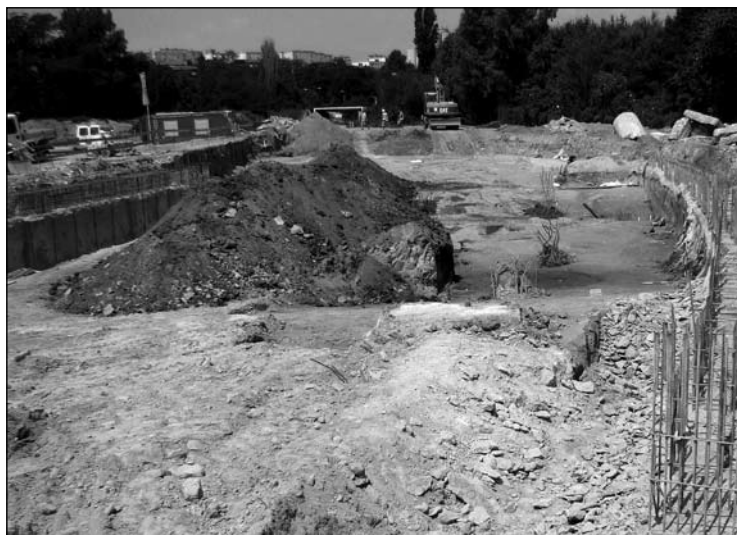
8. kép: Az „E” rámpa területe déli irányból feltárás közben Fig. 8: Area of ramp “E” from the south during excavation
